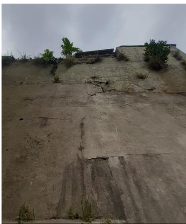
Ansicht der Mauer vom unteren Nachbarn
